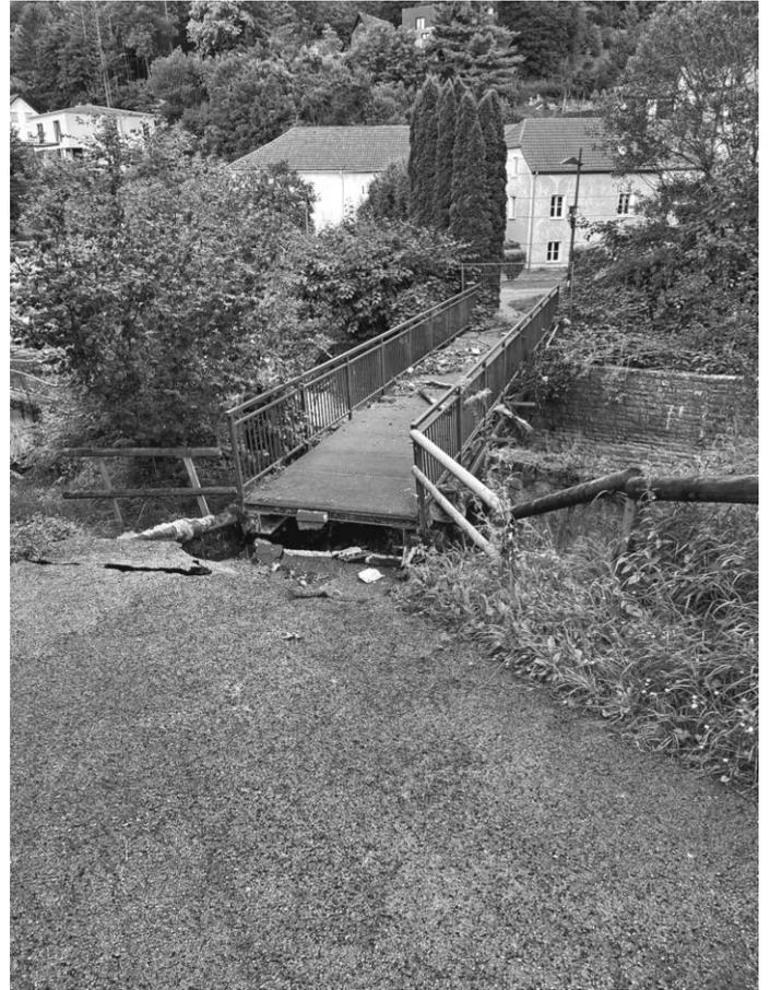
*Die Flut spülte das Fundament dieser Brücke im Zuge eines Radwegs am Orteingang von Irrel weg.*
